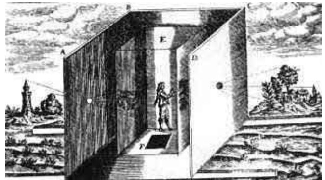
Grande Câmara Escura em forma de liteira, construída em Roma 1646 por Athanasius Kircher
